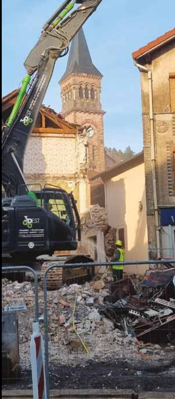
DÉMOLITION ANCIEN MAGASIN PROFILI
