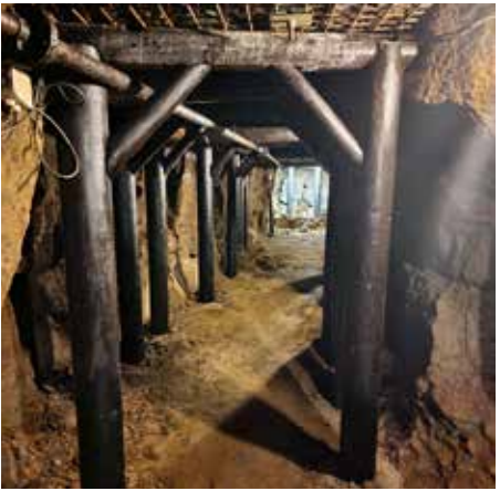
Détails des techniques de soutènement des galeries
