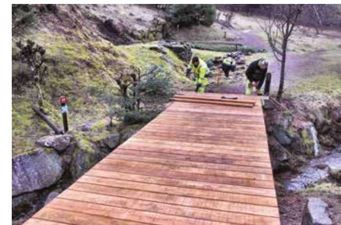
Réfection du pont du site des Hautes Mynes par les services techniques
