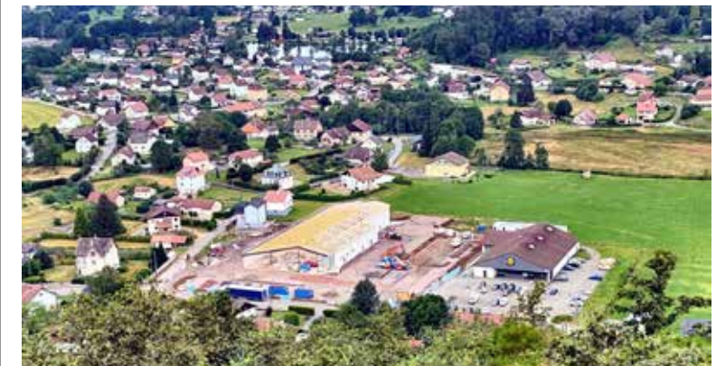
Le chantier du nouveau Lidl au Prey
