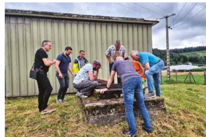
Le nouveau forage du puits du Prey, enjeu de taille pour l'approvisionnement en eau
