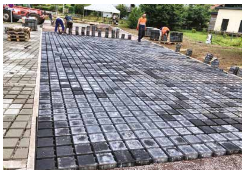
L'aménagement du parking de l'étang de Chaume
