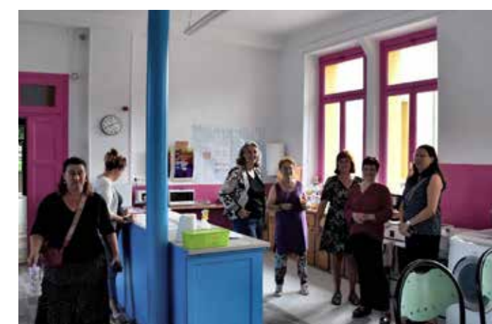
La salle Thérèse Aubert de l'école du centre en pleins travaux
